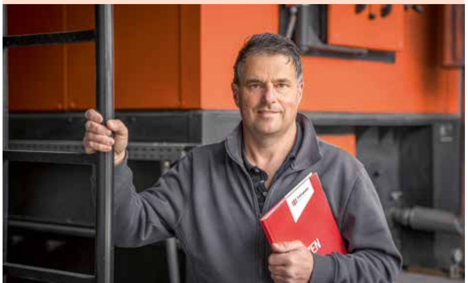
Martin Dirnberger 负责监控施库博的热能回收系统，该系统每天 24 小时运行。
